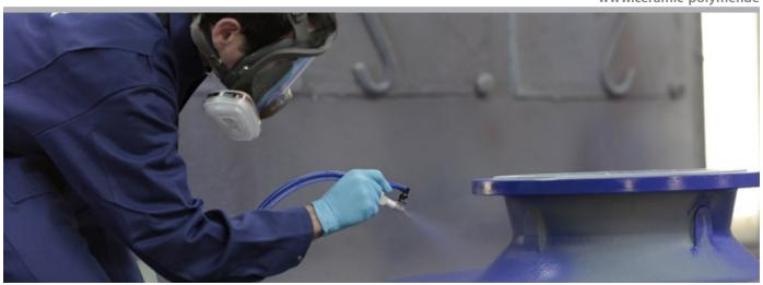
Ab sofort bieten wir für ausgesuchte Produkte die Kartuschenanwendung mit der fortschrittlichen Sulzer Mixpac-Technologie an! Die aufwändige Prozedur der Beschichtungsapplikation wird so deutlich erleichtert. Eine optimale, kostensparende Lösung für Kleinprojekte, schwer zugängliche Bereiche oder Reparaturmaßnahmen!
